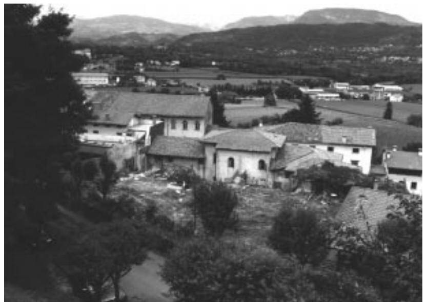
Sbancamento del nuovo parcheggio in via Ciro di Pers
